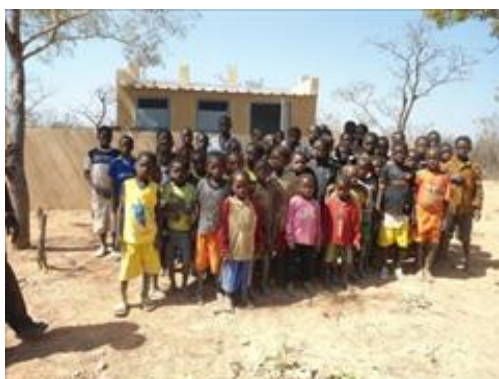
Neu gebaute Schullatrine
